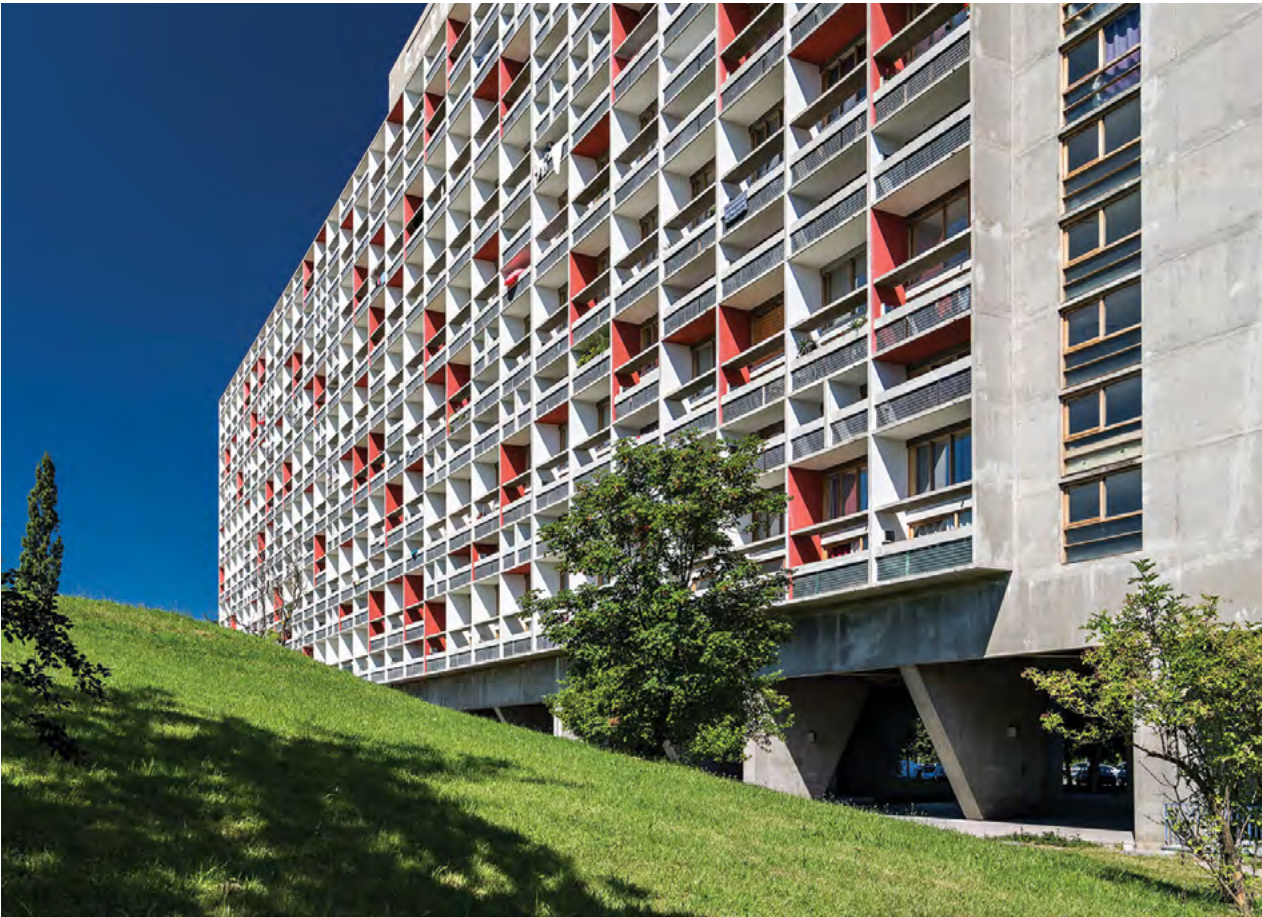
Le Corbusier, Unite d'habitation, Marseille, 1947-53
