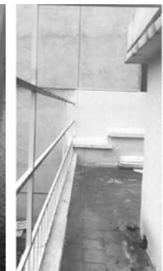
فضای تراس قبل از بازسازی
