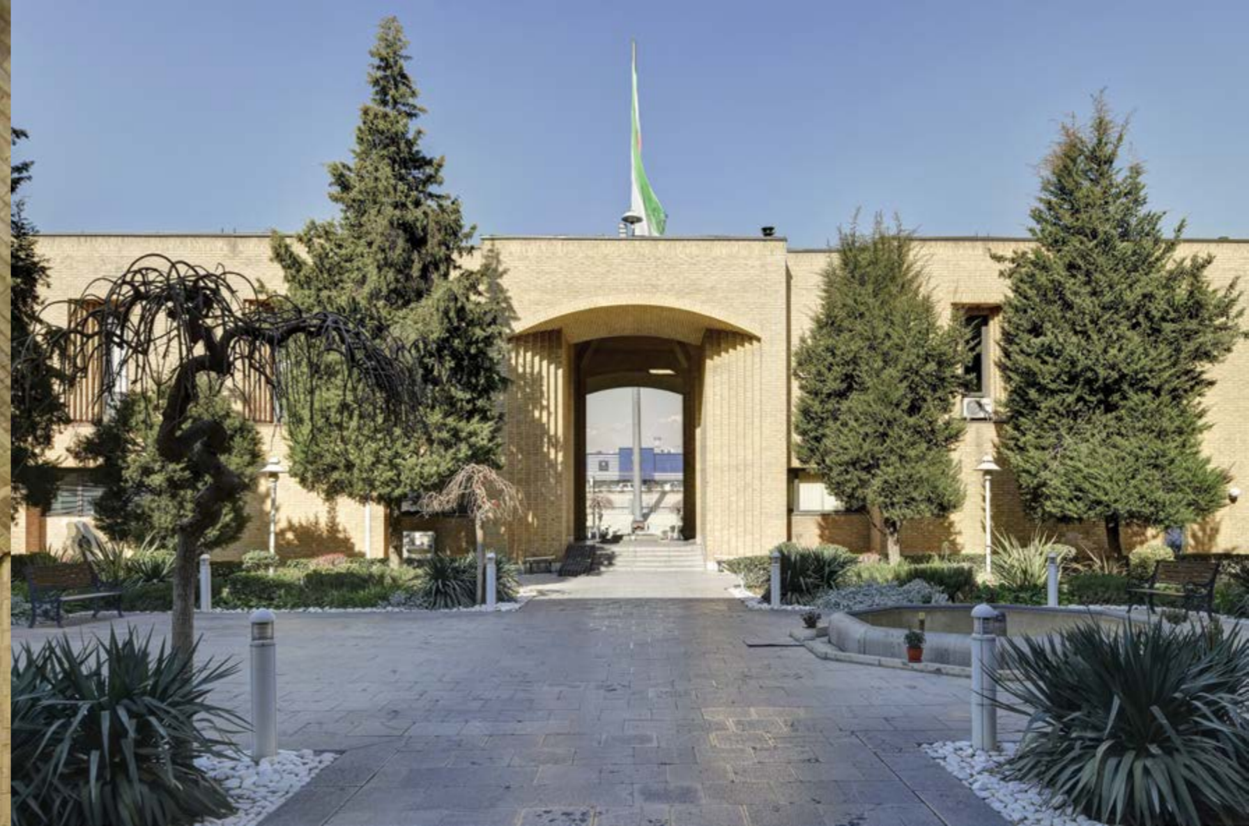
فضای بیرونی به سمت جنوب
