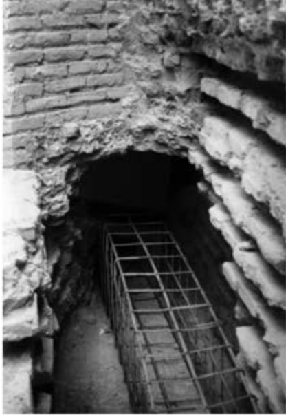
عملیات آرماتوربندی و کمربند بتنی دور گنبد توسط سن پائولزی در سال ۱۳۵۱، منبع: پیسانی، ۲۰۲۰ میلادی
