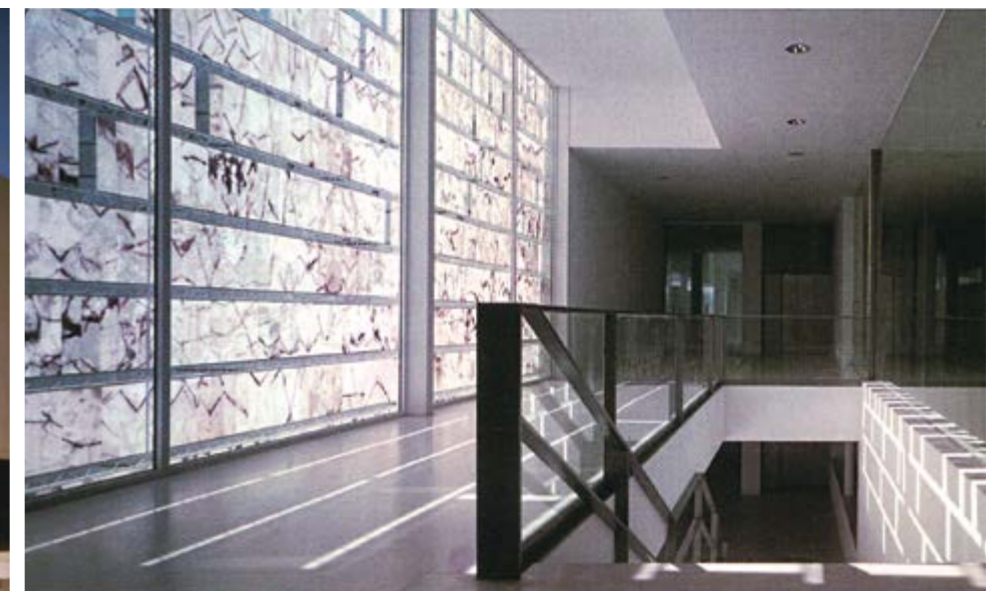
دفتر معماری سانچو مادریدهوس (Sancho Madridejos)، تالار شهر سن فرناندو د هنارس (San Fernando de Henares)، مادرید، ۱۹۹۹
