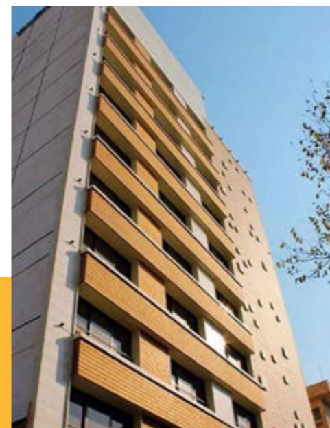
ساختمان اداری ونک
