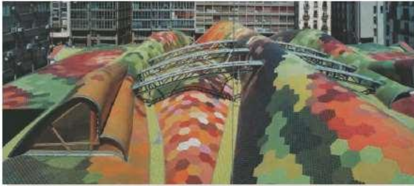
سقف با مساحت ۵۵۰۰ مترمربعی خود، شامل ۳۲۵۰۰۰ شش‌ضلعی از ۲۷ رنگ مختلف است. پوشش سقف مواجی را در برمی‌گیرد که به وسیله‌ی مفاصلی چوبی متکی بر تیرهای فولادی با مقاطع و محورهای متفاوت، شکل گرفته است.
