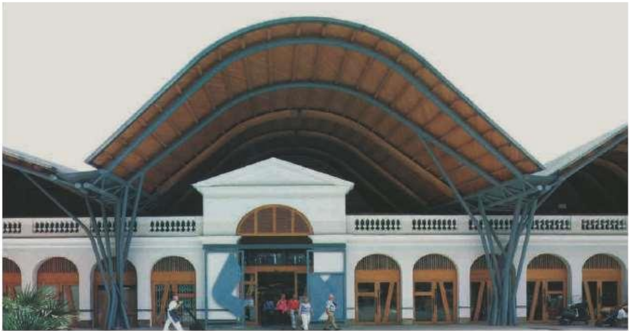
سقف بازار جدید از یک سو بر فراز تپای نئوکلاسیک ساختمان قدیمی مطلق است. از طرف مقابل، «رومیزی» رنگارنگ، آتریومی را می‌پوشاند که کمبود فضای عمومی در این منطقه‌ی پرتراکم را جبران می‌کند.
