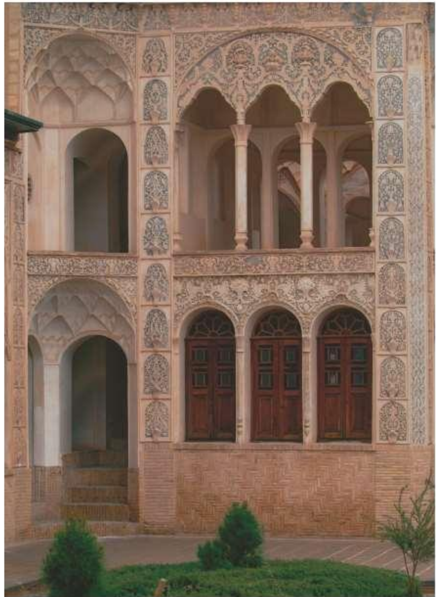
تزئینات گچ‌بری بنا در نمای اصلی
