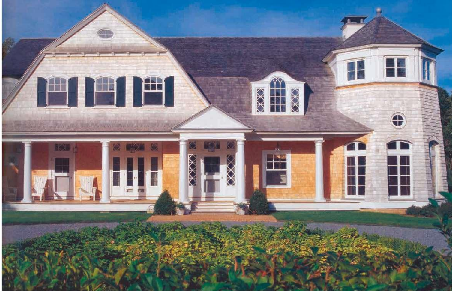
غای بیرونی جلویی؛ سلف خوشب کمرشکن، ایوانها، پنجره‌های نقش لوزی، ستونها و سلف هشت‌گوش یادآور دیگر خانه‌های سبک شینگل سنتی منطقه هستند.
