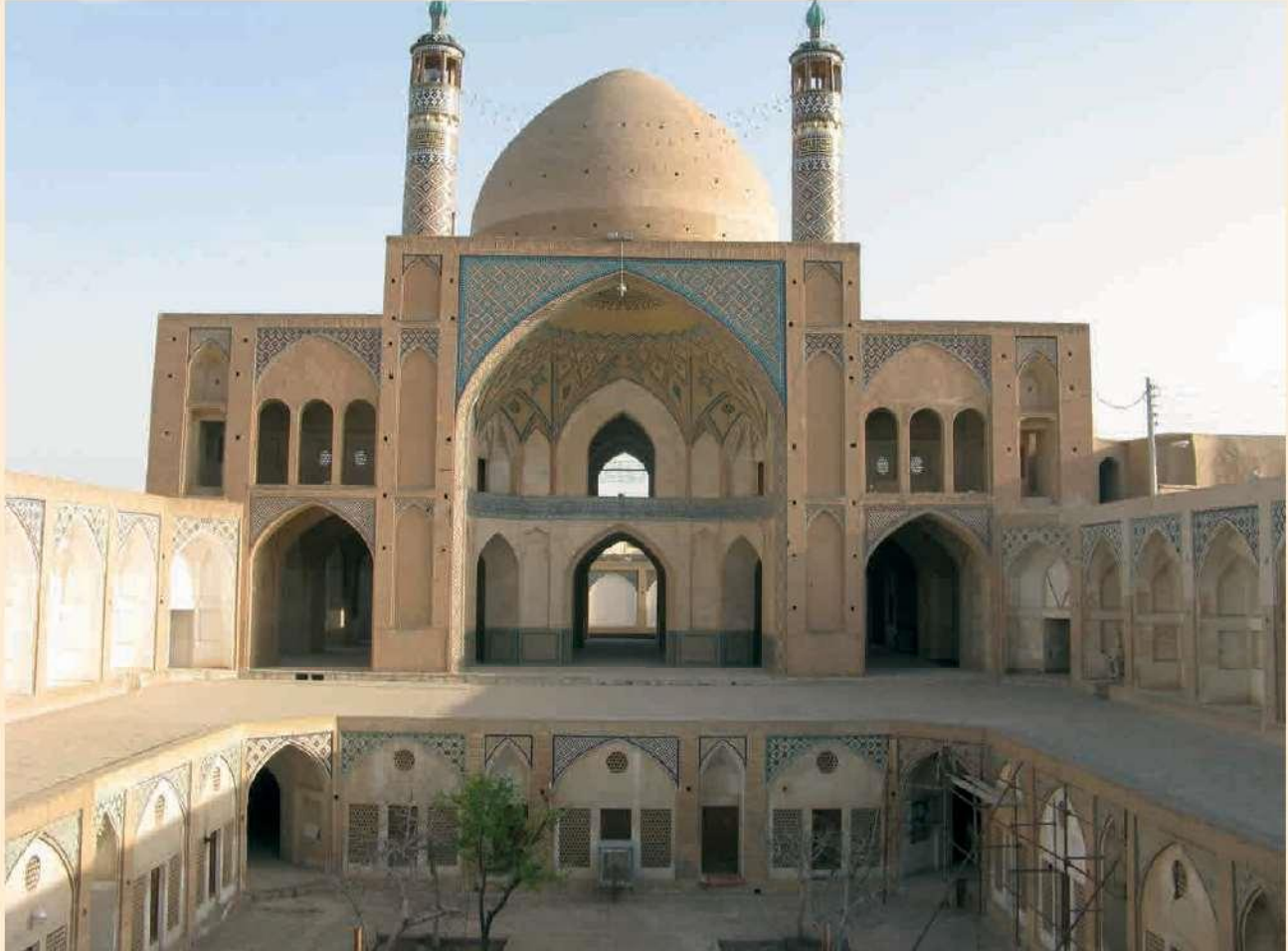
دید کلی از سمت ورودی به سمت مسجد
