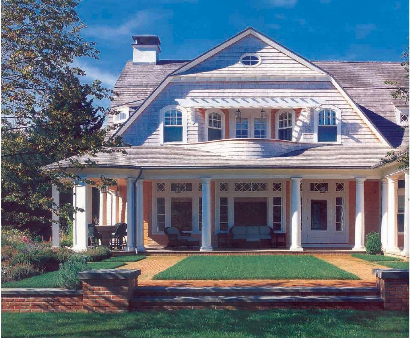
نمای بیرونی پستی: سقف دو شیب کمرشکن شامل یک ایوان و یک بالکن فوقانی در کنار اتاق خواب صاحبخانه است.
