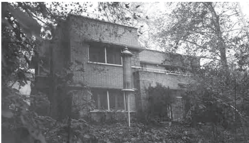
نمای جنوبی و شرقی
