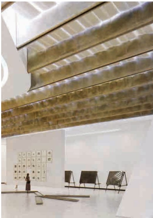
سیستم شبکه‌های فلزی، کرکره‌ها، و کرکره‌های قابل تنظیم برای کنترل ورود نور خورشید به گالریها.
