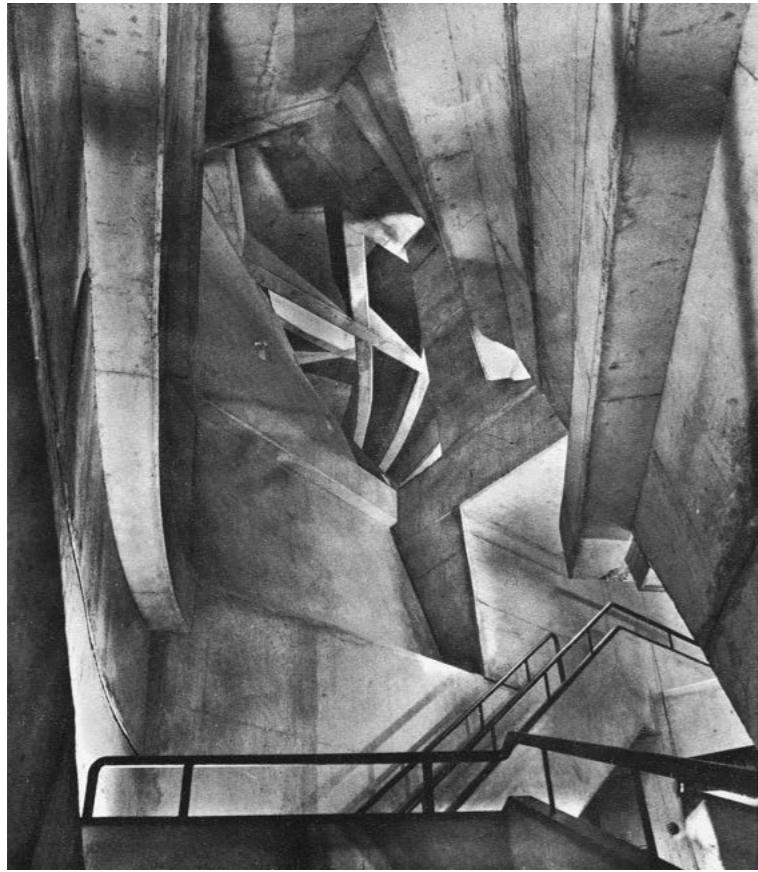
درون یکی از پایه‌های اصلی برج آزادی و فضاهای داخلی که در نمای آن‌ها سطح بتن به صورت نمایان حفظ شده است.
