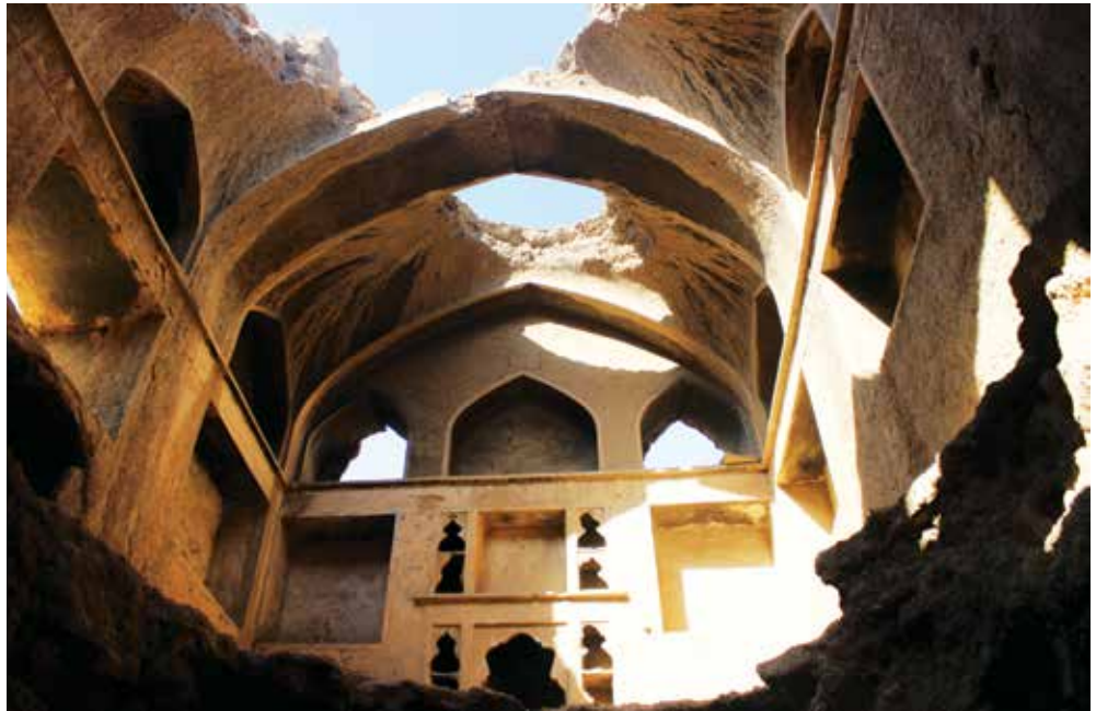
نمونه‌ای از خانه‌های مسکونی قلعه‌ی مورچه‌خورت که تخریب شده است.
