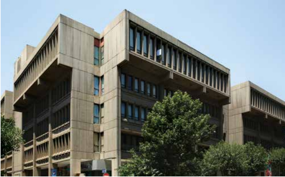
دید به نمای شرقی و جنوبی در ساختمان اداری گروه صنعتی بهشهر (وزارت آموزش و پرورش فعلی)
