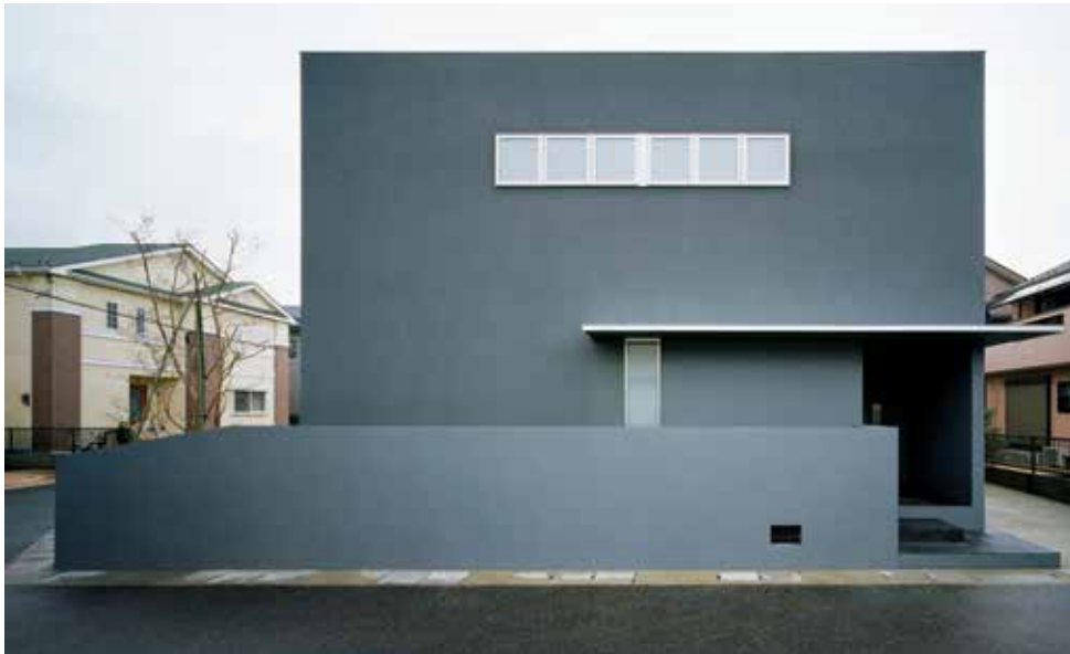
← دیوار کوتاه مقابل ساختمان، پاسیو را از دید رهگذران و همسایه‌ها محفوظ می‌دارد.
