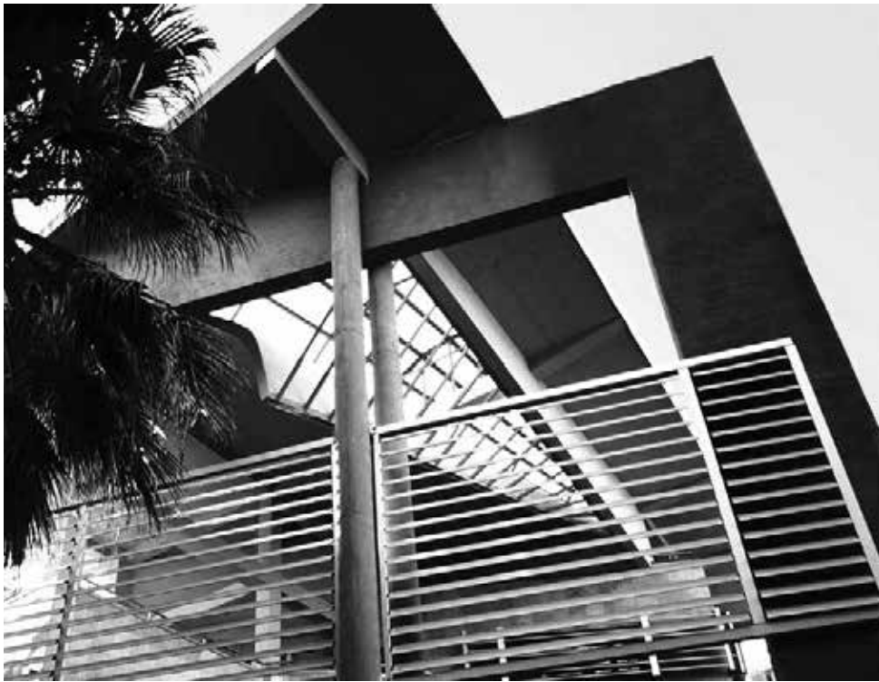
↑ ↑ ۴ سفارت ایران، تیرانا، آلبانی، ۱۳۸۴ طراحی در دفتر مهندسين مشاور تجير [عكاس: جواد بنكدار]
