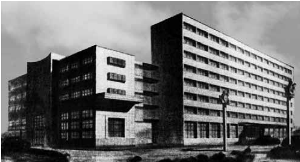
ساختمان وزارت صنایع، تهران
