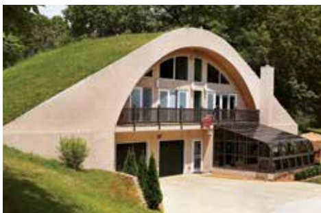
تصویر ۶. خانه‌ای ساخته شده توسط کریگ و دنت تامسون در ایالت ایلینوی آمریکا - که به «ایالت چمن‌زار» مشهور است. (ترکیبی از اسکلت بتنی و خاک پوشیده شده) [Retrieved June 7, 2016. From: http://www.goerie.com/article/20140830/REWEB02308309981/ ]
