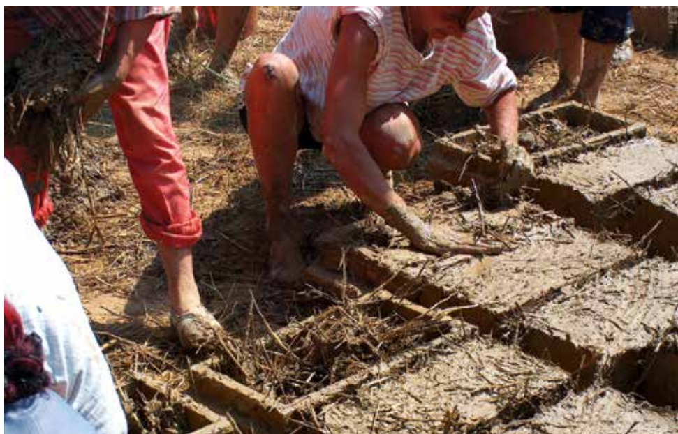
تصویر ۱۲. ساخت خشت با قالب‌های چوبی (گاهی در ساخت خشت، برای استحکام بیشتر از کاه نیز استفاده می‌کنند).
