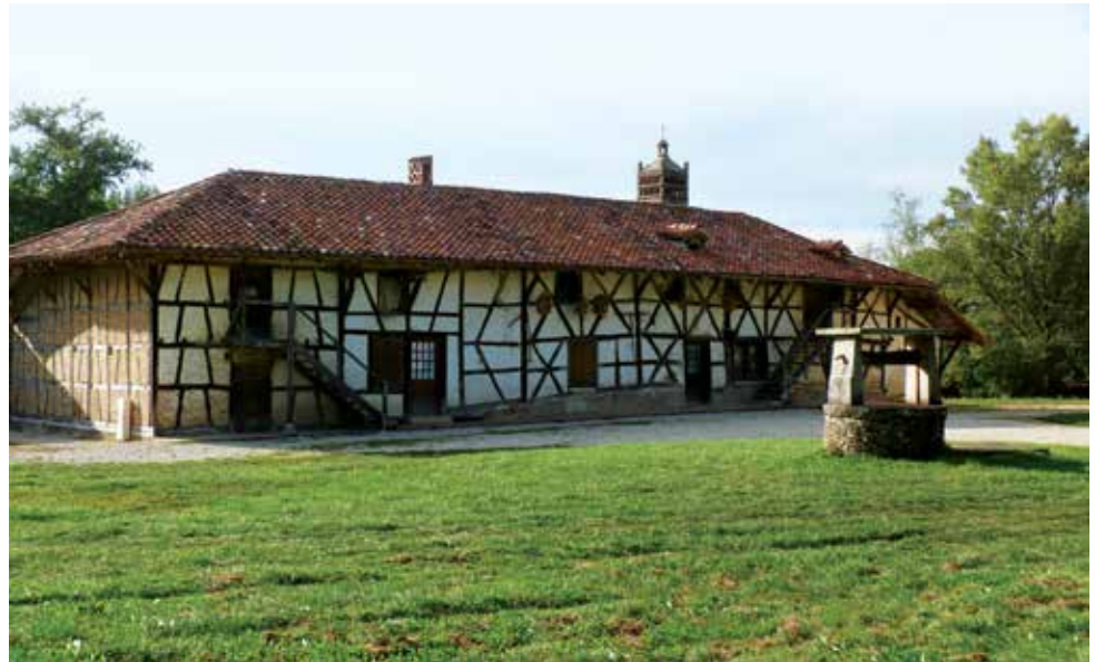
تصویر ۱۵. دادگاه سنت تریوییر، پارس، فرانسه (شبکه‌بندی چوب‌ها کاملاً قابل تشخیص است). [Retrieved June 7, 2016. From https://commons.wikimedia.org/wiki/Category:Ferme_de_Sougey ]
