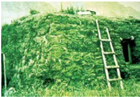
تصویر ۳. خانه‌ای ساخته شده از بلوک‌های چمنی، بریتانیا [Retrieved August 29, 2016. From http://www.earth-auroville.com/cut_blocks_en.php ]
