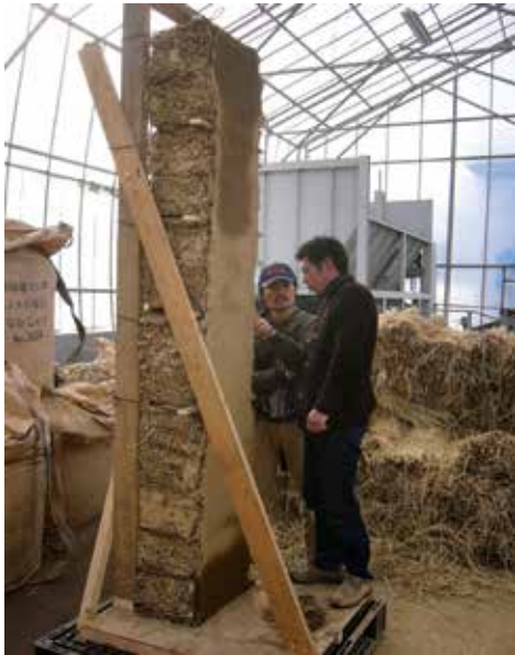
تصویر ۱۶. دیوار ساخته شده با بلوک‌هایی از مخلوط گاه و رس [Retrieved September 8, 2016. From http://holzhueter.blogspot.com/200911/straw-clay-block-test-wall.html ]
