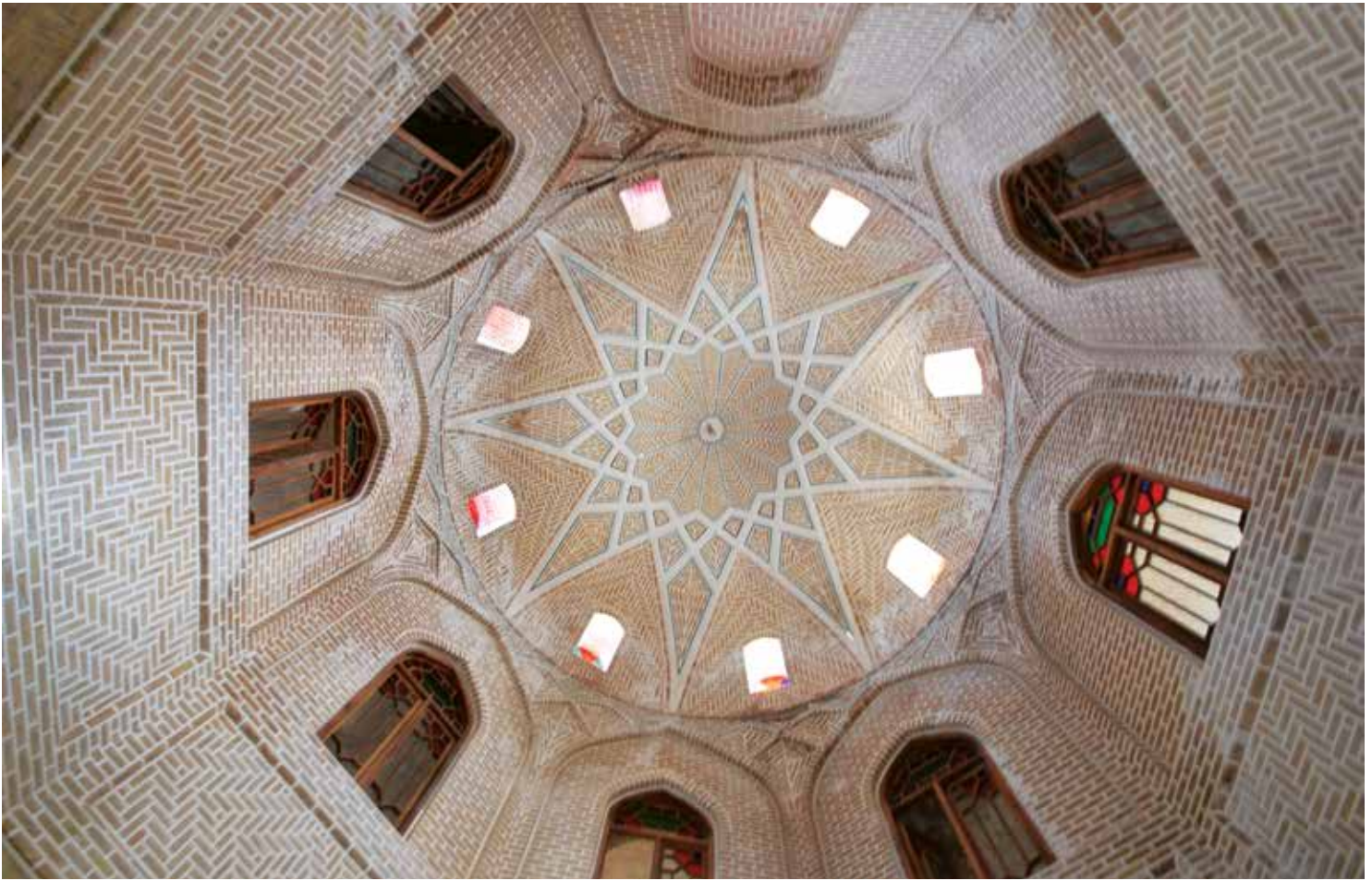
تصویر ۲۴. سقف هشتی ورودی کاروانسرای یامی، مرنده، آذربایجان شرقی
