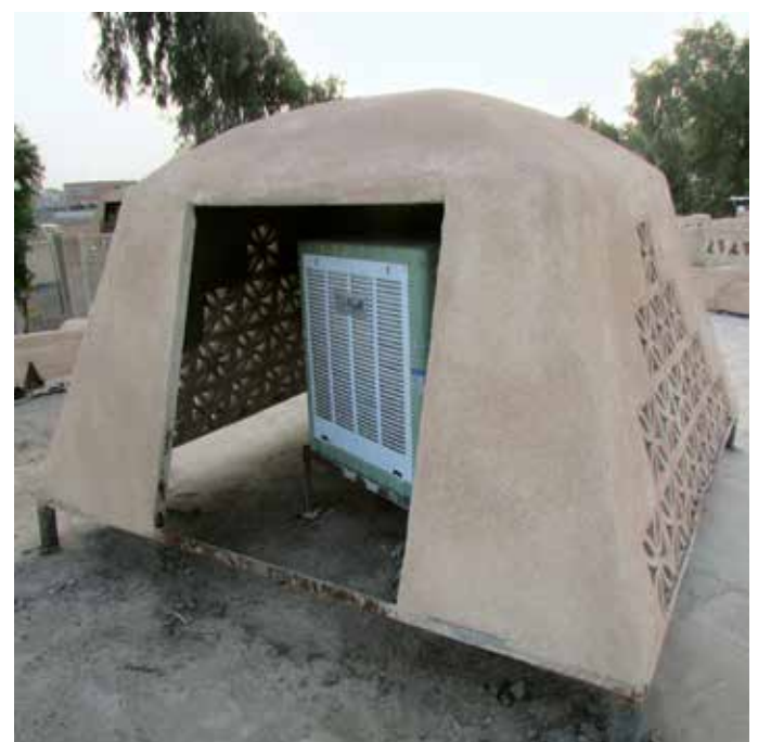
اتاقک کولرها، ساخته شده با مواد همسان با دیوارها
