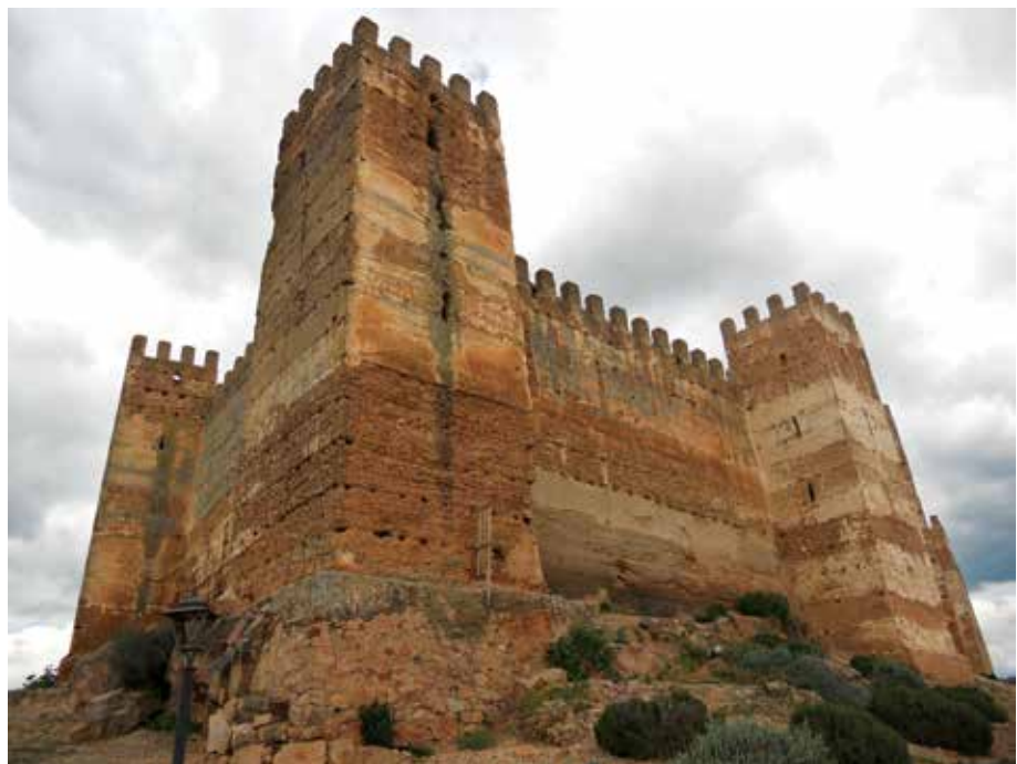
↑ تصویر ۸. قلعه‌ی بورقالیمار، خائن، اسپانیا (های لایه‌لایه‌ی دیوارها بیانگر تکنیک ساخت بنا است).
