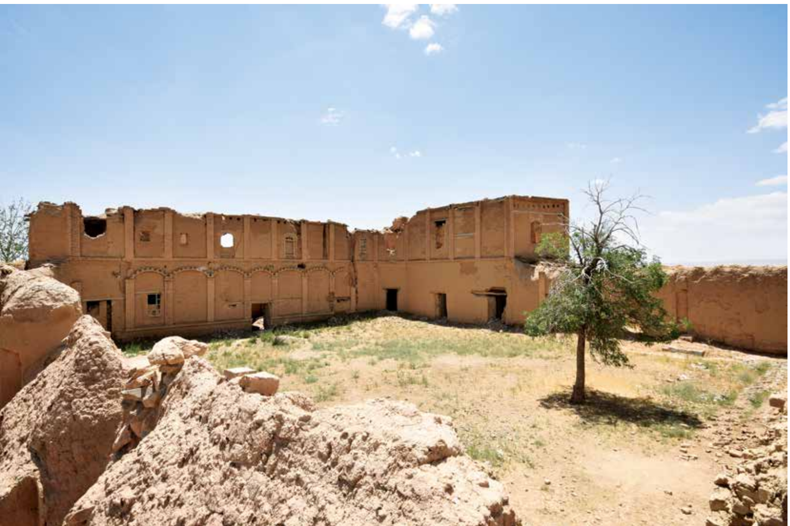
تصویر ۳۰. جرزها و حیاط داخلی قلعه‌ی دورباش، تکاب، آذربایجان شرقی
