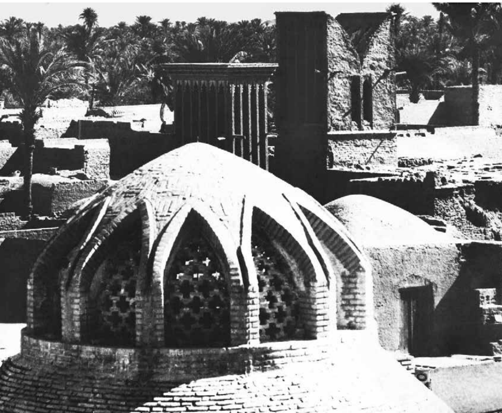
بادگیر و گنبد با نورگیرها و هواکش‌ها در بافق، یزد [مأخذ: رایتر، ۱۹۷۷: ۱۶۱]
