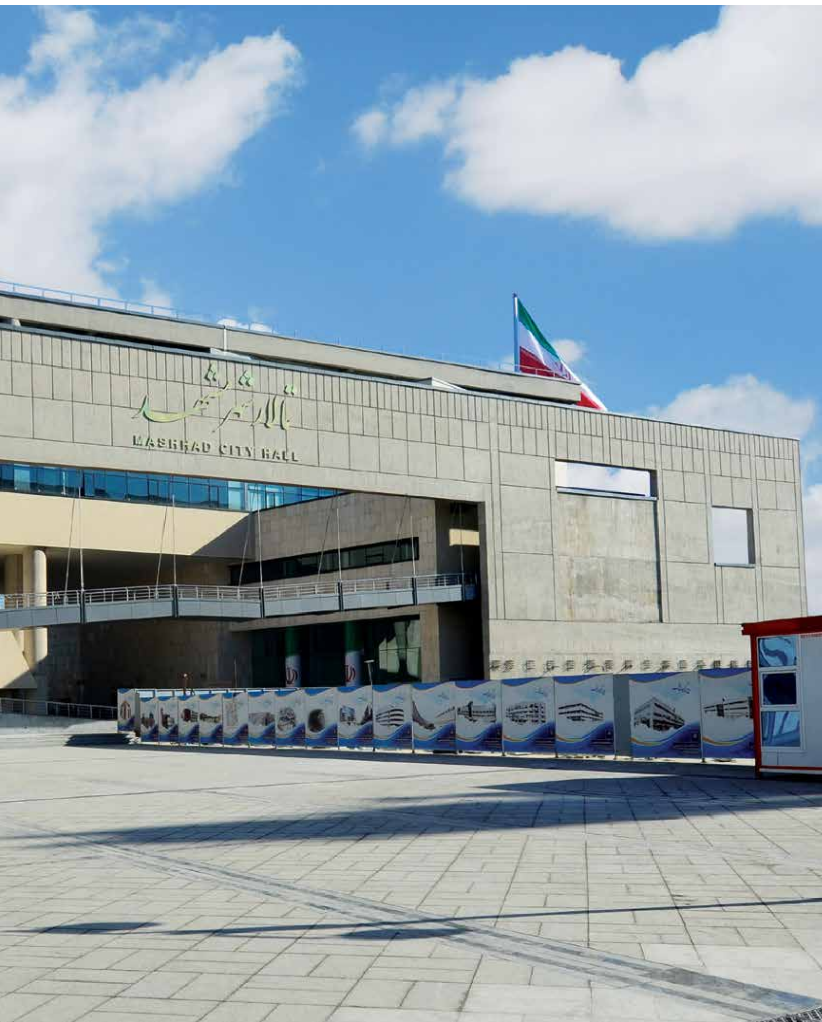
نمای رو به میدان ساختمان تالار شهر، شیپ‌راهه‌ی درون دروازه و قوس اتصال کف سنگی میدان به دیوار بتنی
