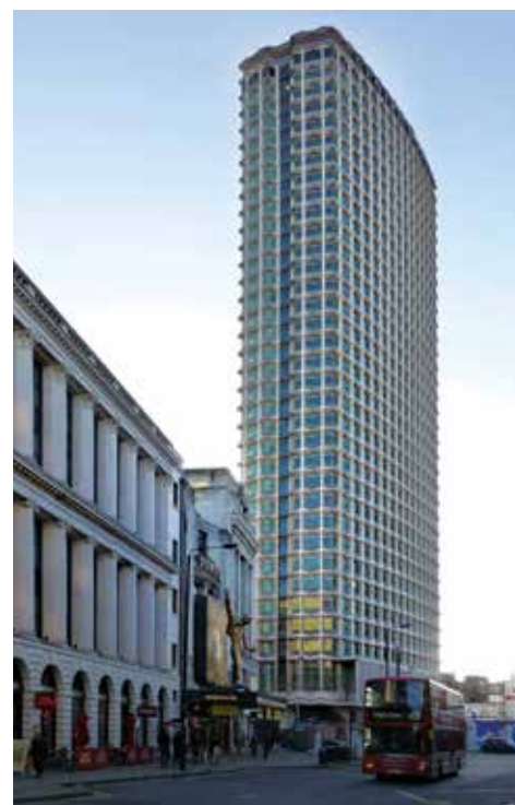
تصویر ۲. ساختمان اداری سنتر پُینت، ریچارد سایفرت، لندن، انگلستان، ۱۹۶۶.
