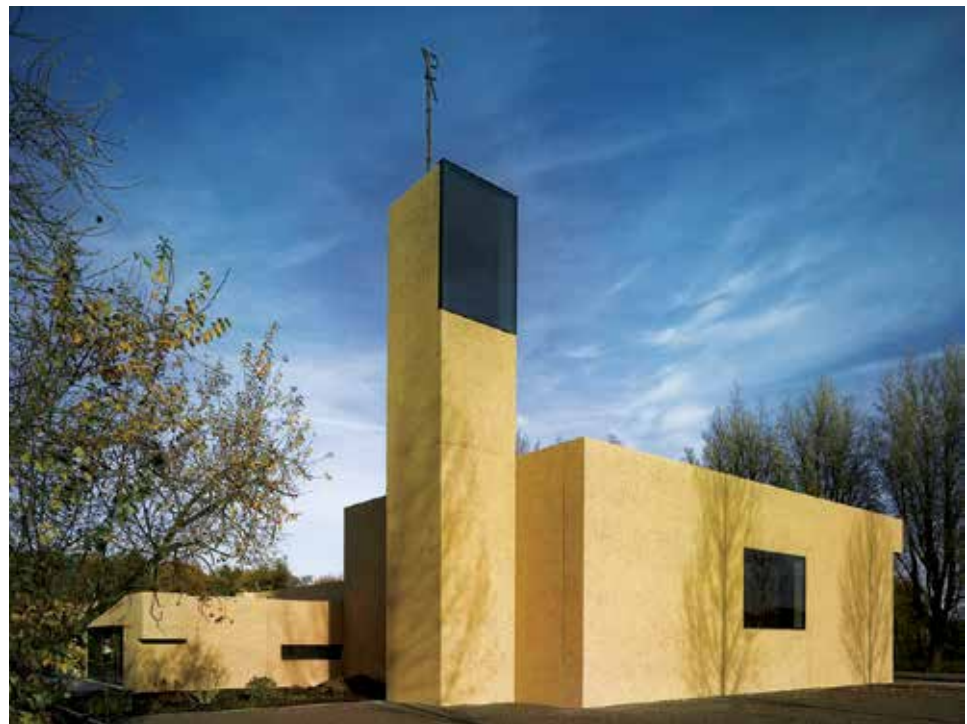
تصویر ۱۷. کلیسای بازسازی‌شده‌ی هلندی، کلاوس کان، هلند، ۲۰۰۶
