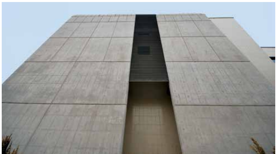
دیوار بتنی ضلع غربی ساختمان تالار شهر
