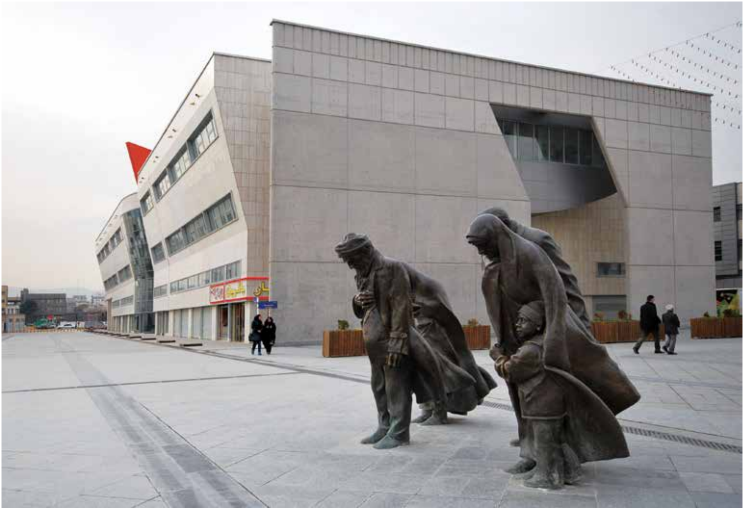
دیوار بتن اکسپوز شمال ساختمان تجاری اداری شمس با شکاف خمیده به سمت حرم
