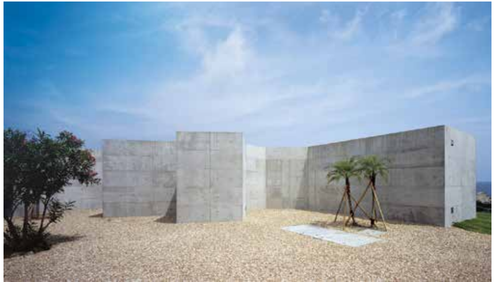
تصویر ۱۴. خانه ی "O"، ژاپن، سو فوجیموتو، ۲۰۰۷
